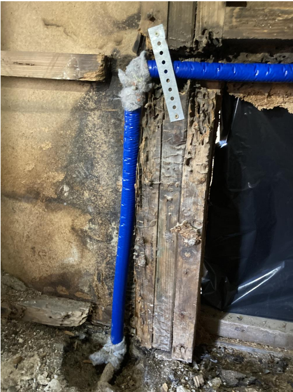
Slika 12: Primer trohnobe na skeletu objekta
