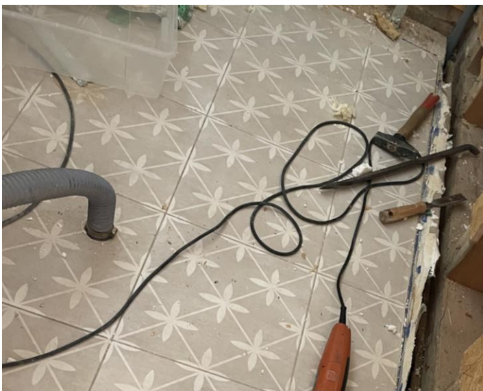
Slika 7: Vpihanje vročega zraka pod estrih
