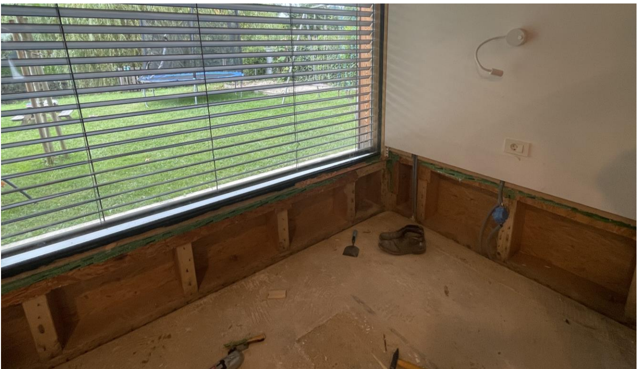
Slika 4: Odstranjevanje stenske obloge. Odstranjena obloga omogoča sušenje sten.
