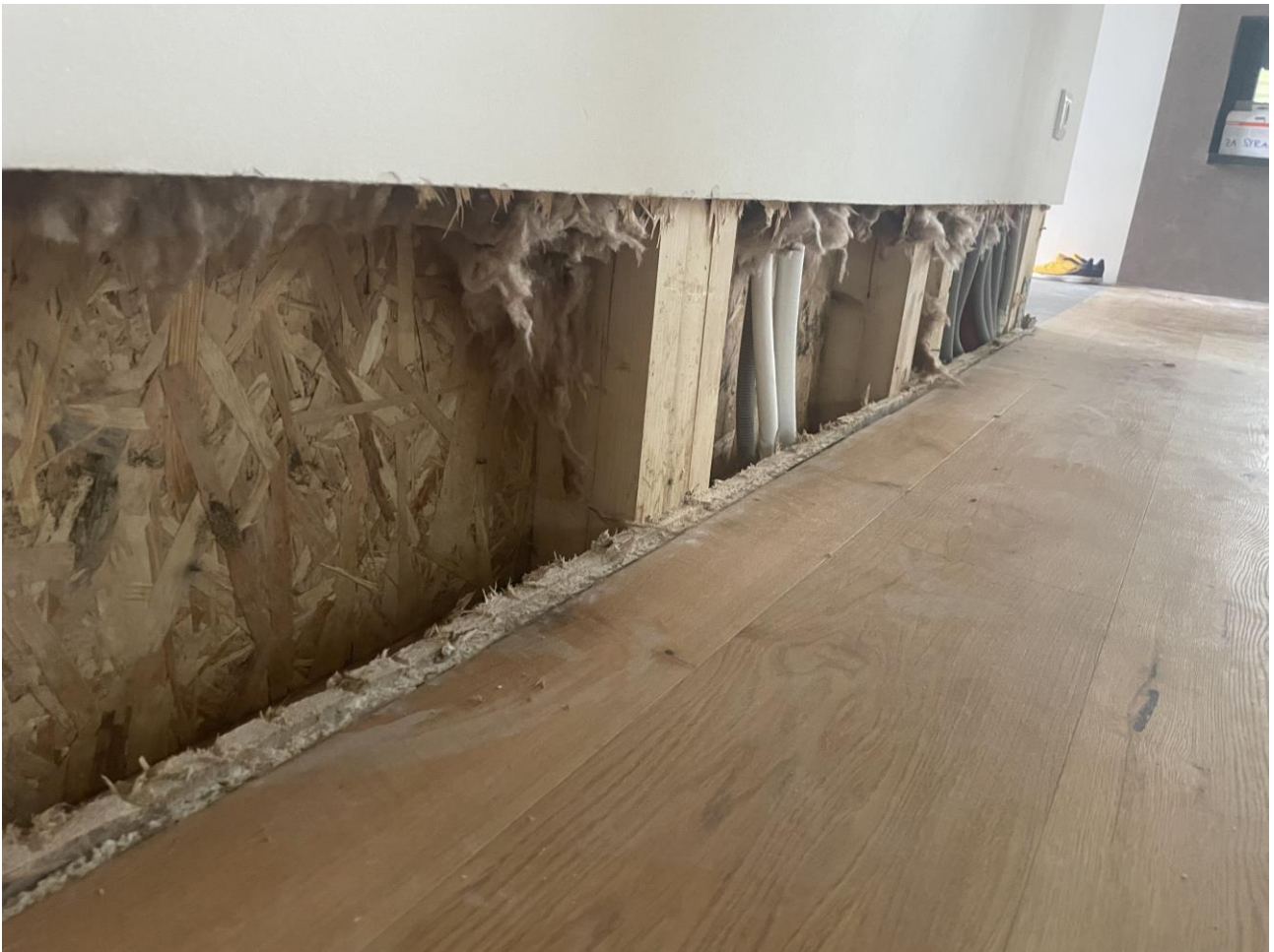
Slika 3: Odstranjevanje stenske obloge. Odstranjena obloga omogoča sušenje sten.
