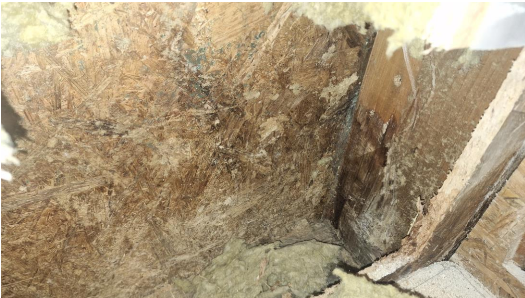
Slika 13: Primer trohnobe na spodnji pasnici ob stiku OSB in pokončnika. OSB se ob stiku s prsti kruši.
