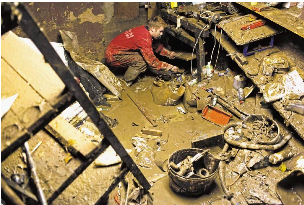
Slika 1: Poplavljen objekt, neposredno po tem, ko je odtekla voda
